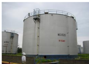
実証試験に用いた石油タンク （直径15.5m、容量1600kL）
