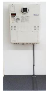
熱のリサイクルにより給湯時のエネルギー効率を高めるエコジョーズでは、その構造上、燃焼運転時にドレン排水が発生します。ドレン排水は下水道法では汚水の位置付けですが、雨水システムへの排出に関する取扱い（ガイドライン）が国交省から発出されました。※1
